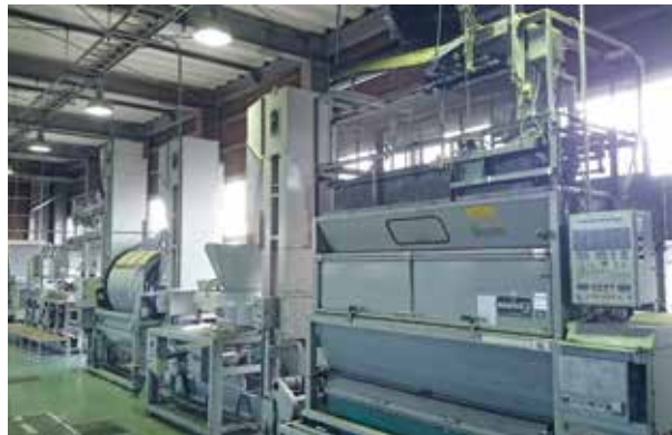
製茶工場内部
