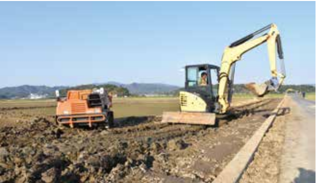
道路の補修工事をするメンバー
